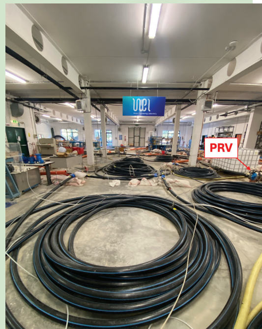
Fig. 2: Rete di distribuzione magliata, oggetto di sperimentazione presso il Laboratorio di Ingegneria delle Acque (Water Engineering Laboratory - WEL) dell'Università degli Studi di Perugia, con la PRV installata sulla condotta di adduzione che alimenta la rete
