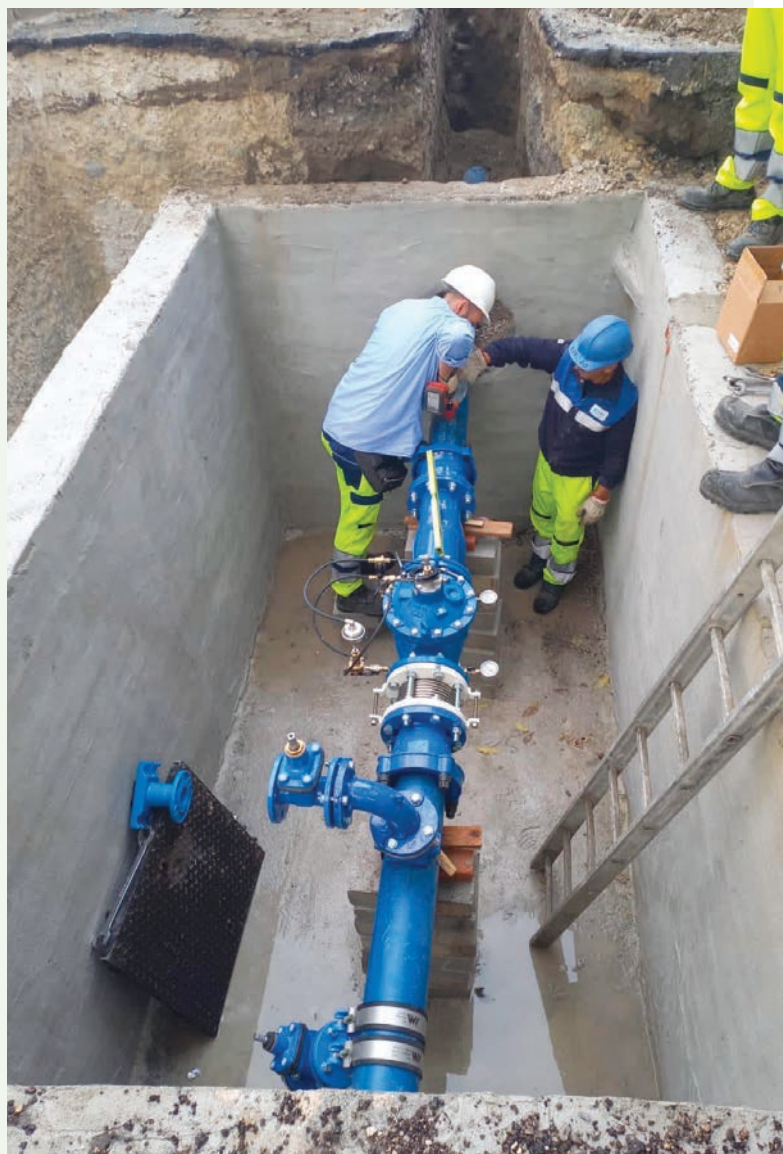
Cantiere cittadino – Installazione idrovalvole
